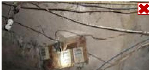
**线路老化，线路未穿阻燃塑料线槽或金属导管保护。**
