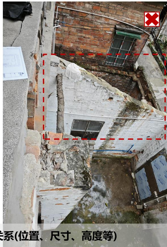
随意增加开间进深和柱高，改变房屋中各建筑的空间关系(位置、尺寸、高度等)
